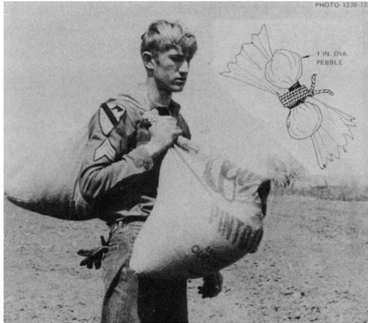
**Fig. 8.1.** Llevando 80 libras (36,287 kg.) de agua en dos bolsas (harpilleras), cada una forrada con dos bolsas de plástico de basura mayores, una dentro de la otra. (Fotografía).
